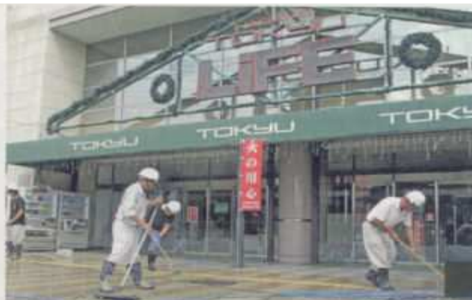
▲北長野ショッピングセンターながのの東急ライフ正面入口前の施工風景
